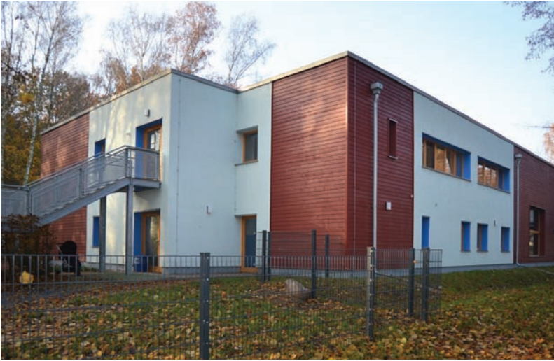
Der Kitabetrieb findet nur in der oberen Etage statt, die derzeit nur über die Außentreppe erreichbar ist
