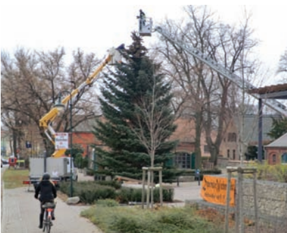
Weihnachtlicher Kirchplatz: Die Feuerwehr stellt den Baum auf, Elektroanlagen Zepernick sorgt für den Lichterglanz
