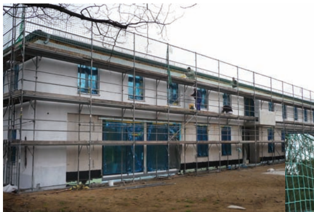
links: Die Fassade wird bereits verputzt
