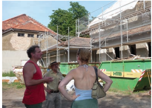
Ulf Heitmann vom Vorstand der WBG „Bremer Höhe“ eG erklärt im Rahmen einer Führung die begonnenen Sanierungsarbeiten
