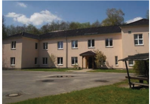
Die Behindertenwerkstatt an der Schönerlinder Straße
