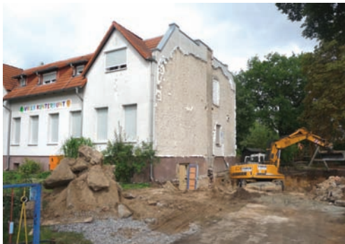
Bauarbeiten an der „Villa Kunterbunt“
